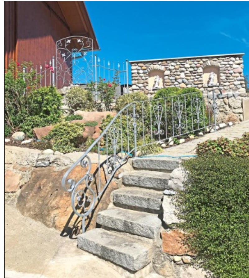
Die Treppe den Garten hinauf zum Gewächshaus ziert ein selbst geschmiedetes Geländer.
